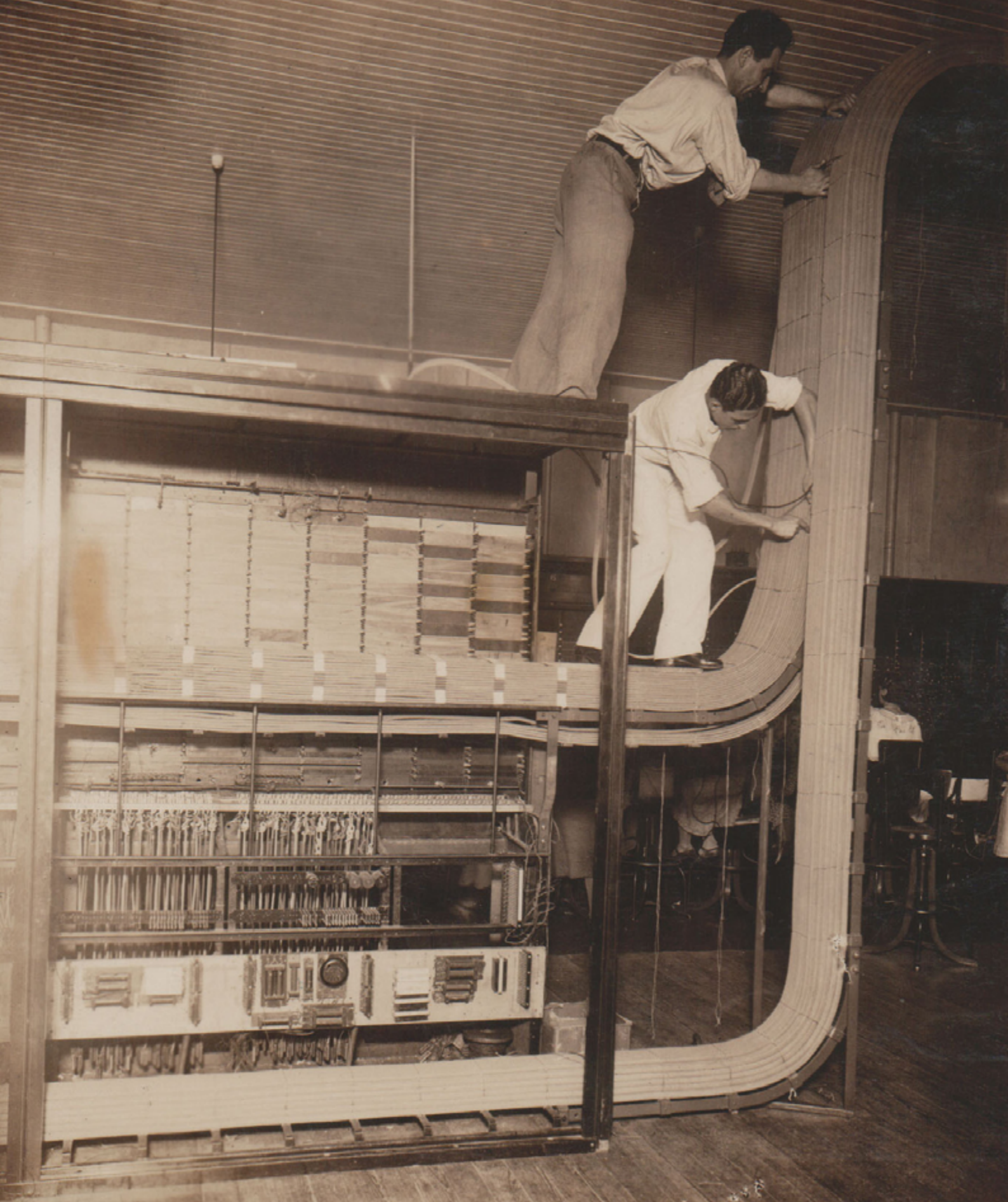
Imagem 2: Nova instalação de cabos para as mesas na Estação "28", 1933. Fonte: Acervo Musehum.
