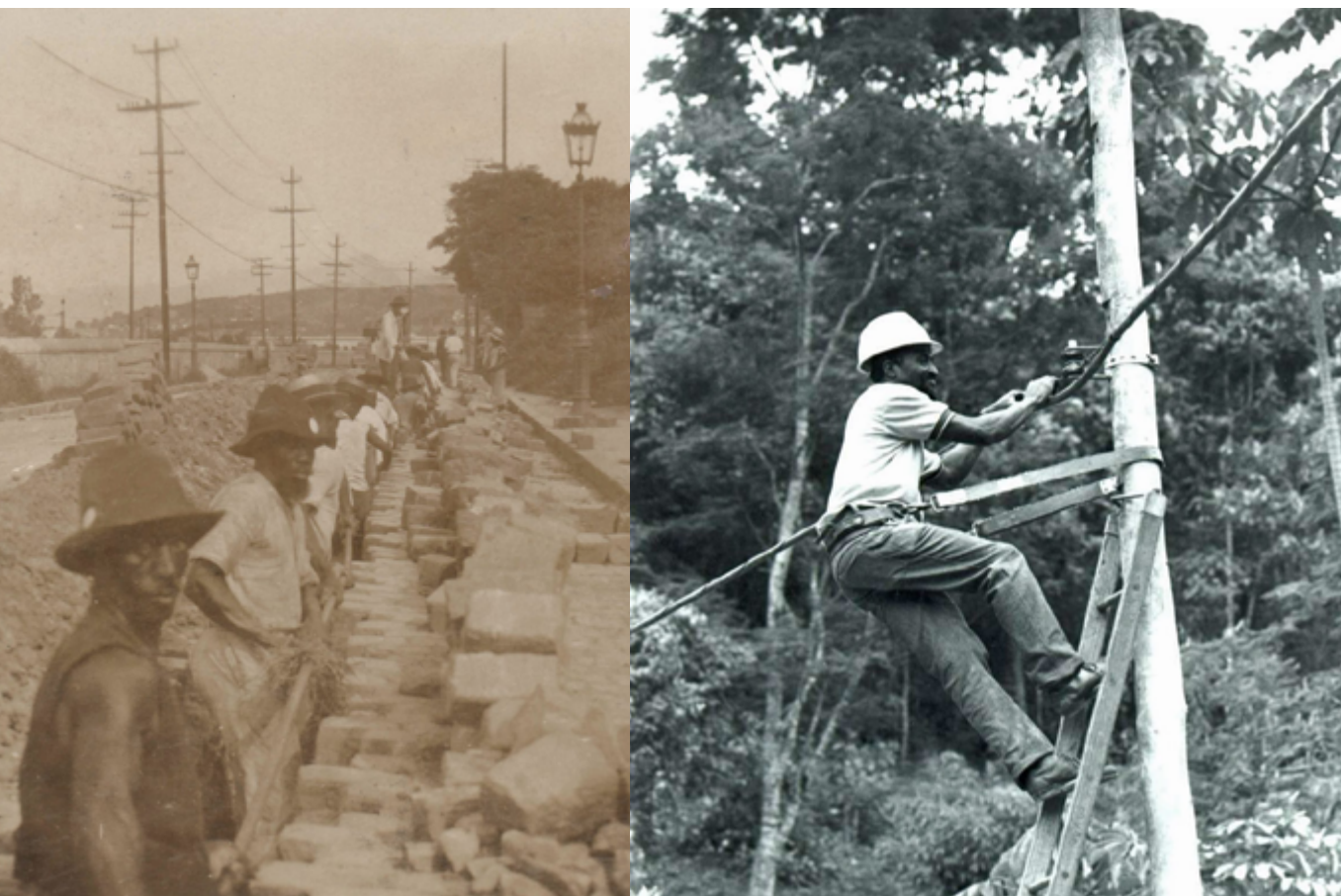
Imagem 4 (esq.): Colocação de cabos na Rua 24 de maio nos anos de 1925-1926. Imagem 5 (dir.): Funcionário trabalhando na rede aérea, década de 1990. Fonte: Acervo Musehum.
